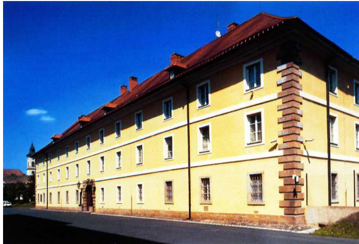
Abb. 21: Die aktuelle Fassade der Magdeburger Kaserne.
