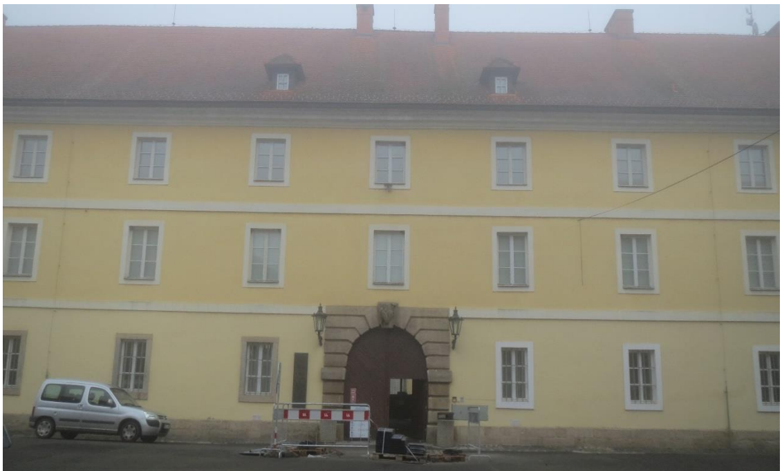
Abb.4b: Magdeburger Kaserne: Hauptfassade. Fotografie. Stadt Terezín. Dezember 2015.
